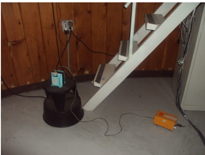
Figura 3: Conexión del transformador y la fuente de alto voltaje al reflector.
