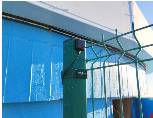
Figura 5: La antena del GPS es instalada de manera temporal sobre la baranda exterior del piso de telescopio. Procurando siempre que los cables no estorben al libre andar del personal. Recientemente se ha adquirido un nuevo modelo de antena receptora, la cual será instalada en una nueva locación de maneja fija.
